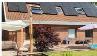
1960-1976 TYPEHUS Luft til vand-varmepumpe, gulvvarme og solceller
